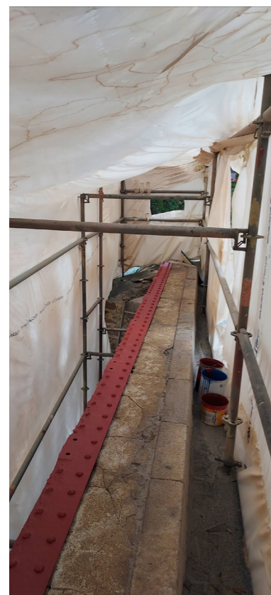
Traitement des poutrelles
