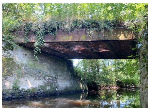
Le pont Beaumanoir avant travaux
