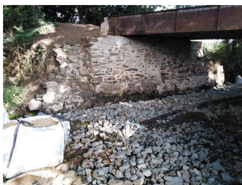
Nettoyage et préparation du chantier
